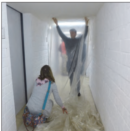
Übung im LGA : Bau einer behelfsmäßigen Schleuse – Anpassen der Foliengröße
