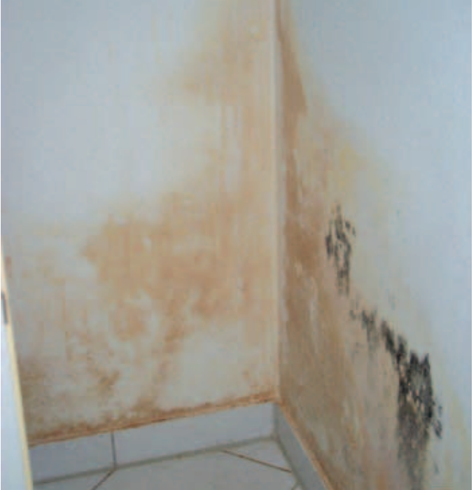
Geometrik ısı köprüsü
